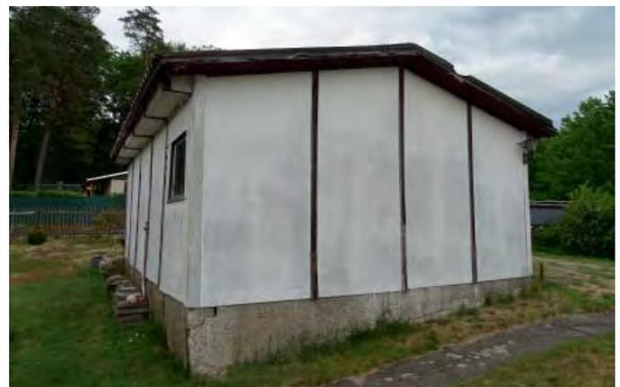
Klassische Asbestlaube aus DDR-Zeiten. Da die Dachplatten beschädigt sind, müssen die Asbestplatten entfernt werden. Bei der Demontage und der Entsorgung sind gesetzliche Vorgaben einzuhalten!
