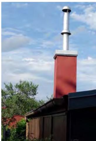
Durch die umfassende Sanierung bzw. den Austausch von Bauteilen bei diesem Schornstein dürfte der Bestandsschutz verloren gegangen sein.
